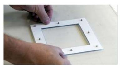
8. Clear IR-4-P の六角ナットまたは蝶ナットを取付けて、8mm の 六角ソケットまたはレンチで締めます。
