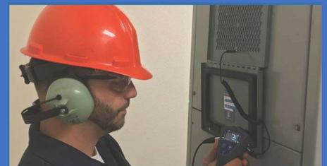
パネル設置型部分放電センサー PDS (オプション) を使用しての検査
